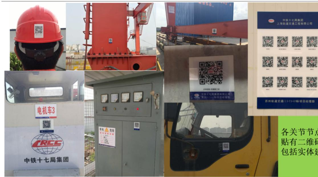
如今，走进苏州地铁3号线1标项目工地，印有“中国铁建”标志的二维码随处可见，只要拿出手机扫一扫，便能了解相应的详细信息，俨然一张细致的“身份名片”，这是项目经理部按照集团公司《关于施工现场大力推广应用二维码信息技术的通知》要求，深入贯彻落实集团公司工程目标标准化、信息化管理要求，创新“互联网+”现场管理模式而推行的一个互联网应用管理工具。
