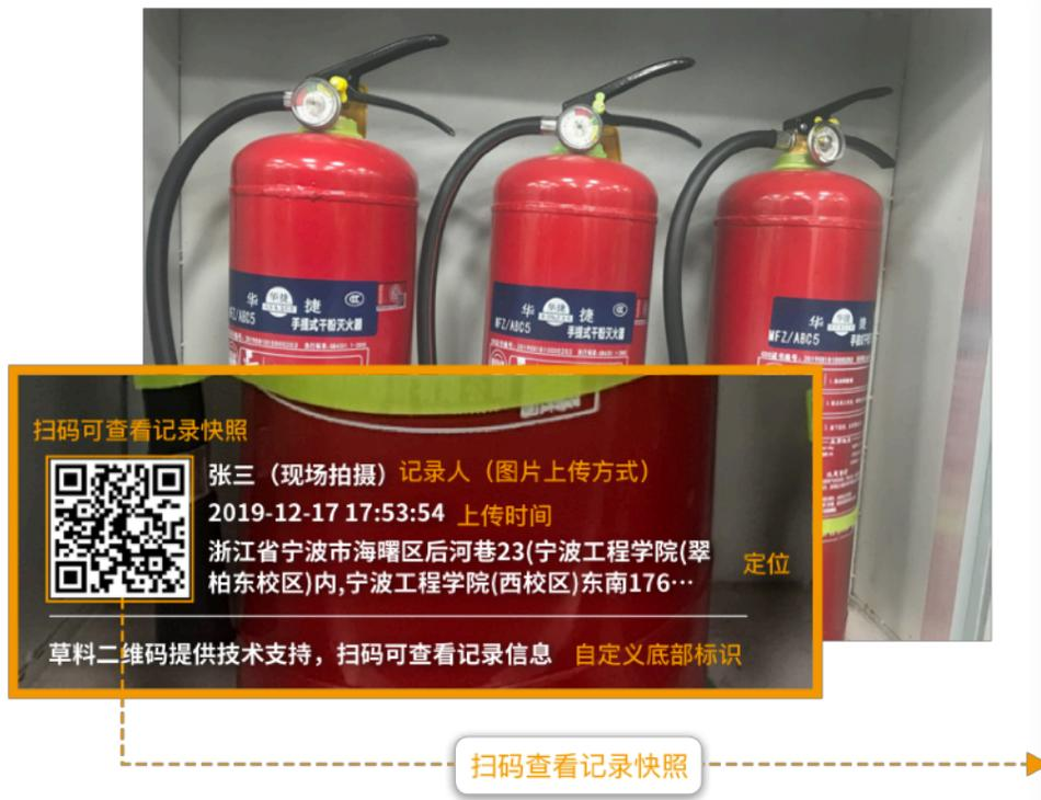
拍摄的照片自动带上水印（包含记录人、上传时间、定位、二维码等）无法被手动修改，让他人代检、不在规定时间检查、伪造现场照片等假检行为都可以被发现
