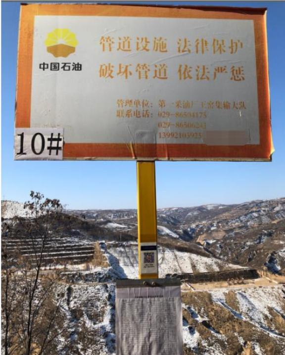
应用于管线日常巡检，在每条管线的巡查点上粘贴上二维码，借助微信平台，巡线人员只需对设置点二维码进行扫描，即可实现巡线时间、地点、管线名称、现场照片、语音、文字等信息自动记录。
