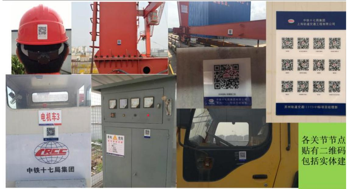
如今，走进苏州地铁3号线1标项目工地，印有“中国铁建”标志的二维码随处可见，只要拿出手机扫一扫，便能了解相应的详细信息，俨然一张细致的“身份名片”，这是项目经理部按照集团公司《关于施工现场大力推广应用二维码信息技术的通知》要求，深入贯彻落实集团公司工程项目的标准化、信息化管理要求，创新“互联网+”现场管理模式而推行的一个互联网应用管理工具。
